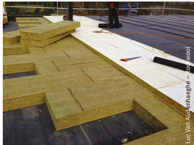
Fig. 62 Pose de panneaux de laine minérale.
