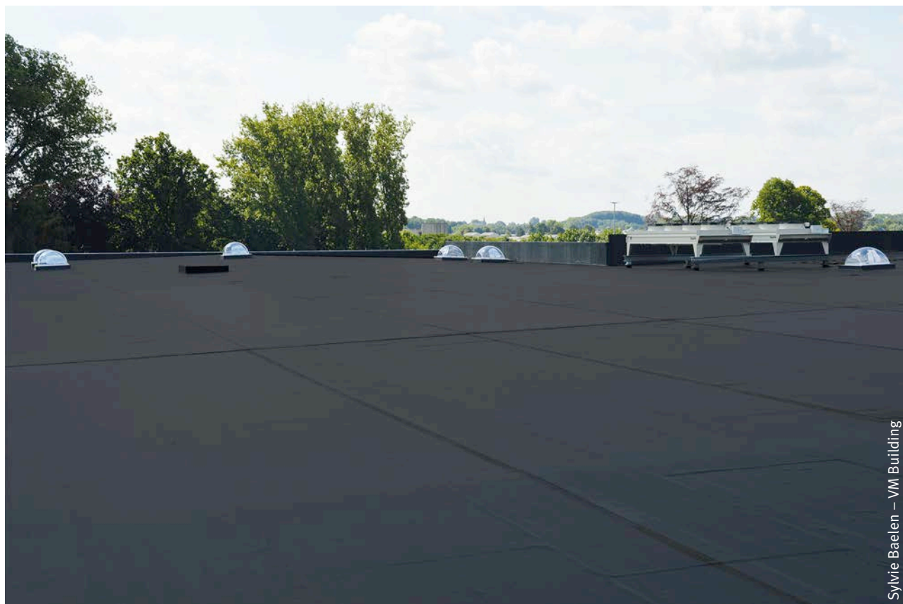
Fig. 76 Étanchéité en EPDM.
