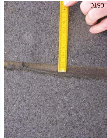
Fig. 128 Retrait dans une étanchéité bitumineuse.
