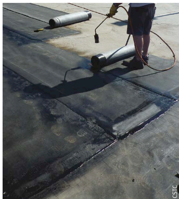
ÉTAPE 2 - JOINT TRANSVERSAL ENTRE LE LÉ 'B' ET LE LÉ 'C' ; JOINT LONGITUDINAL ENTRE LE LÉ 'C' ET LE LÉ 'A'
