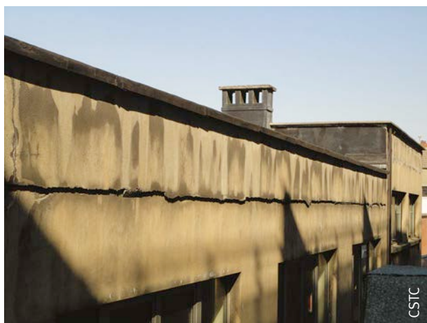
Fig. 25 Températures extrêmes sur une toiture munie d'une isolation sous le support.
