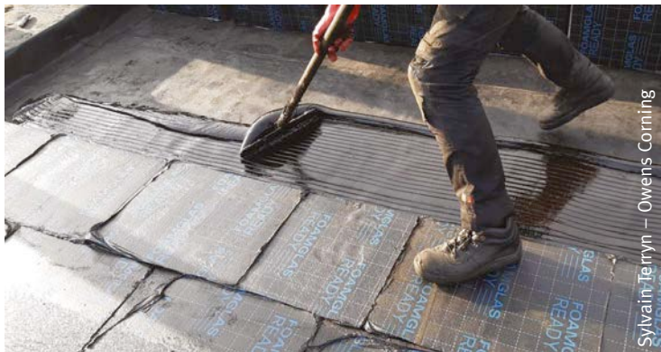
Fig. 64 Application de colle bitumineuse à froid.
