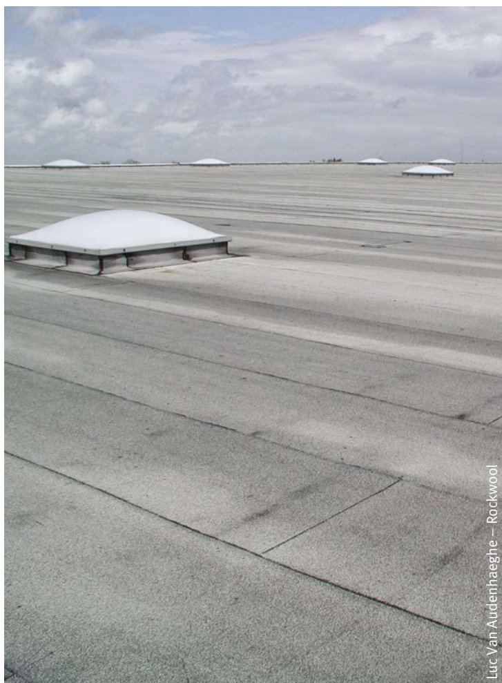
Fig. 68 Toiture munie d'une étanchéité bitumineuse.
