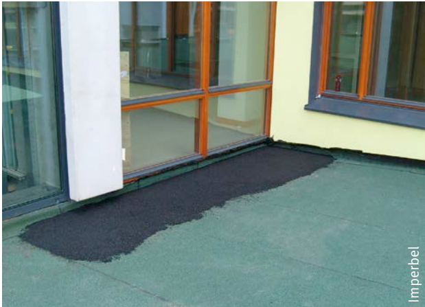
Fig. 98 Masse bitumineuse de remise à niveau.
