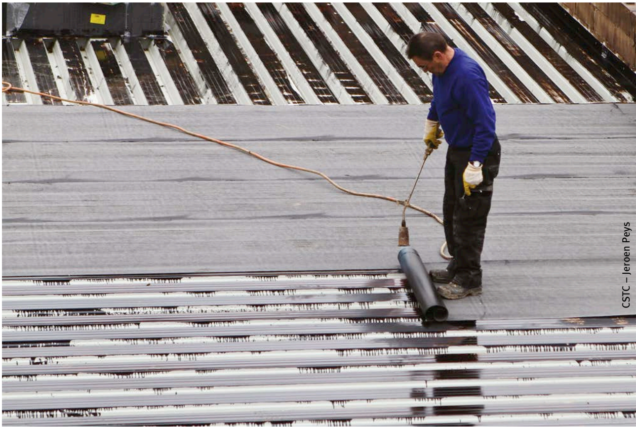
Fig. 56 Pose d'un pare-vapeur bitumineux sur un support en tôles d'acier profilées.
