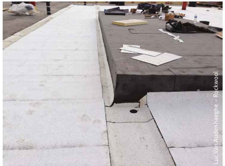
Fig. 69 Couche d'étanchéité finale en bitume pourvue de granules blanches réfléchissantes.
