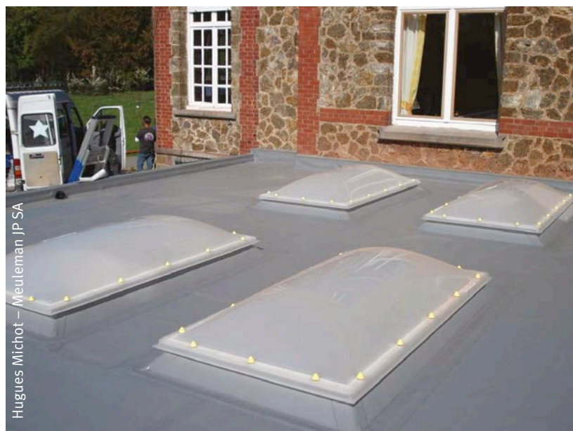
Fig. 82 Étanchéité en PVC.
