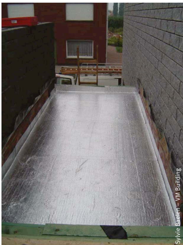
Fig. 55 Pare-vapeur autoadhésif en aluminium.
