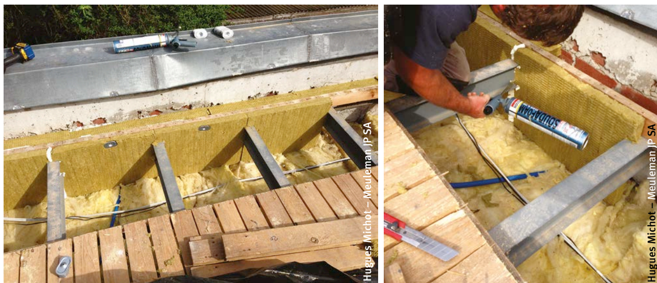
Fig. 97 Ouverture de la rive en saillie en vue de son isolation.
