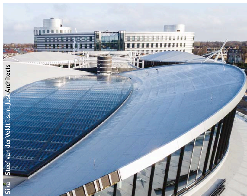
Fig. 83 Étanchéité en FPO.
